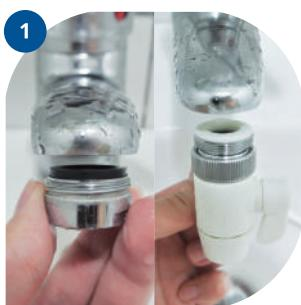
Снимите со смесителя аэратор и установите распределитель на наружную резьбу крана
